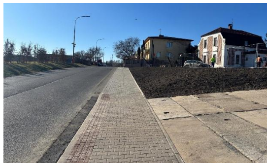
Opravy Lidické ulice a nový chodník v Přemyslovské ulici, foto: Tomáš Novotný
