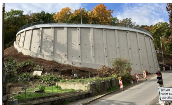
Poslední fáze oprav serpentiny, foto: archiv města Roztoky
