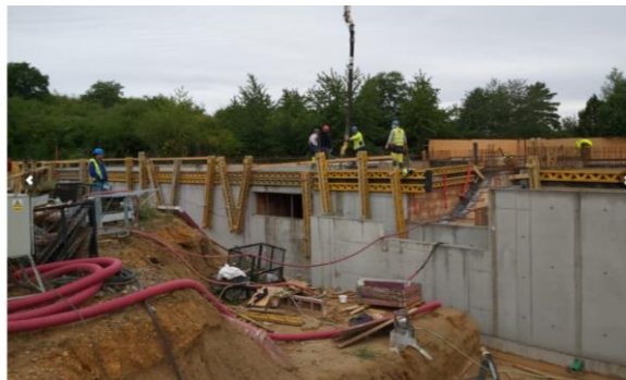
Výstavba nové školní budovy
