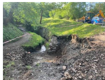
Oprava zdi u žalovského potoka, zdroj: soukromý archiv Tomáše Novotného
