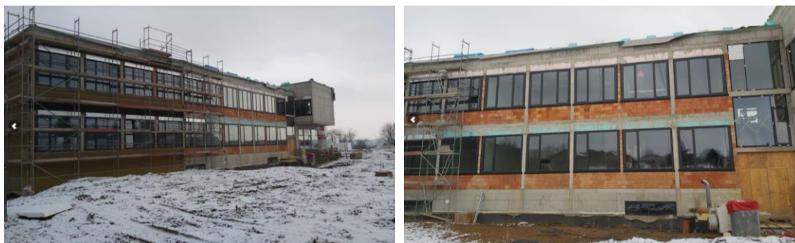
Výstavba nové školní budovy,
