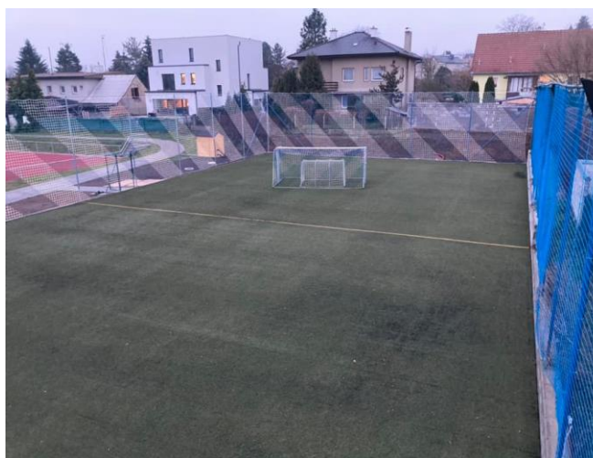
Oprava hřiště s umělým povrchem, zdroj: https://www.facebook.com/skroztoky
